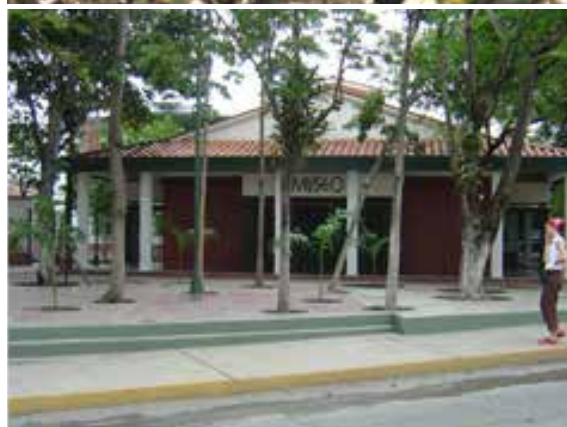
Vistas antes y después de la intervención
