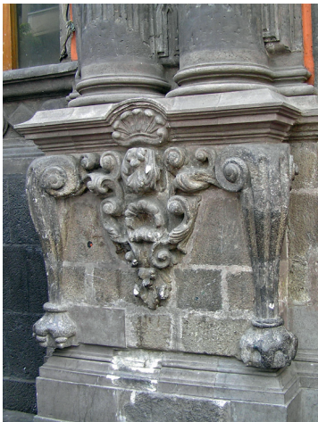
Base de doble semi-columna del Palacio de los Condes de Santiago Calimaya en la Ciudad de México.
