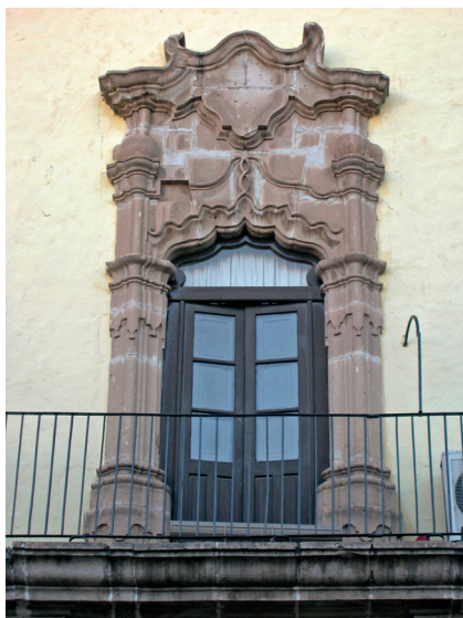
Vano del nivel superior del Palacio Zambrano.
