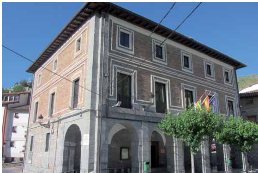
Lám. 20. Escuelas de Soto de Cameros. Fachada principal. Torcuato Benjumeda. 1821.
