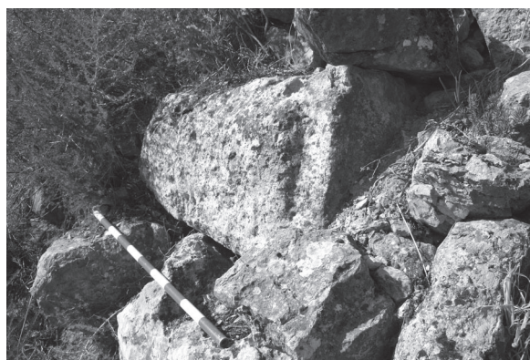
Lám. 3: Detalle de aparejo ciclópeo en el recinto amurallado de Torre Alta, con sillar almohadillado (Fuente: MHM Priego).
