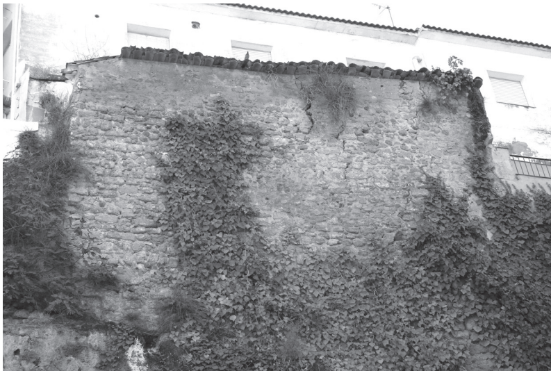
Fig. 41: Sector 5. Lienzo de muralla sobre el tajo, que recae sobre el Recreo de Castilla, con edificación similar a UEM 1020.
