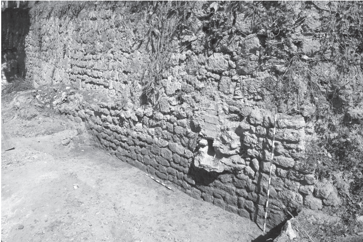
Fig. 32: Sector 5. Zanja para apoyo de la pieza de conexión con la muralla en primer término documentada (UEM 1019).
