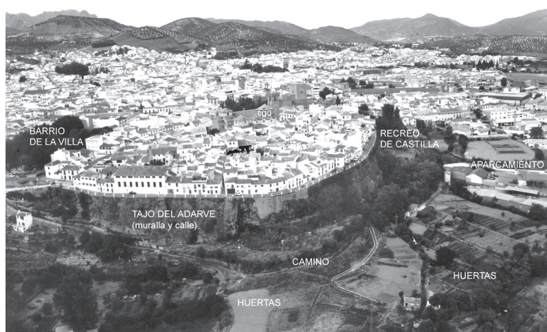
Fig. 1: Vista aérea de Priego, con la localización del Recreo de Castilla, el Tajo y muralla del Adarve.
