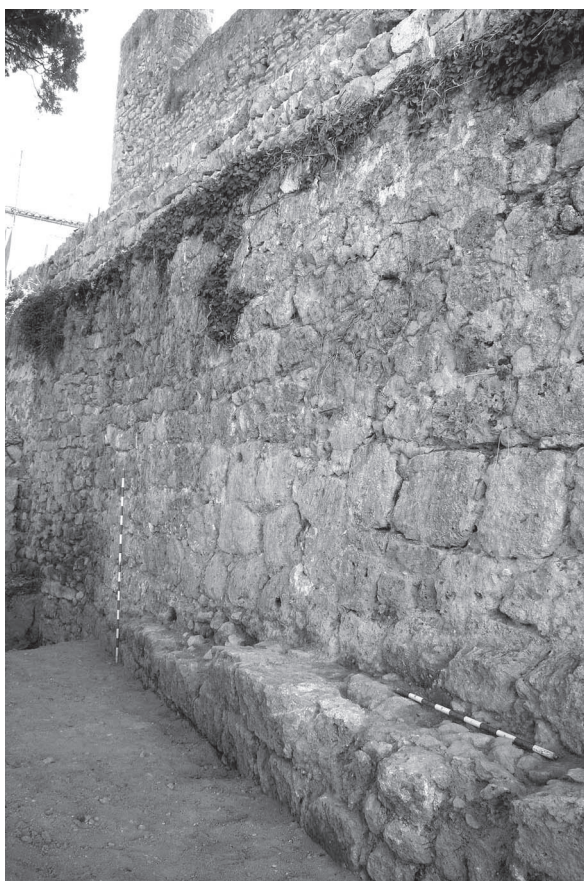
Fig. 39: Sector 5. Alineación de muralla documentada sobre la cual están construidos los muros de contención del Recreo, lindando con calle Adarve y el castillo, cuya esquina N se ve arriba, al fondo.
