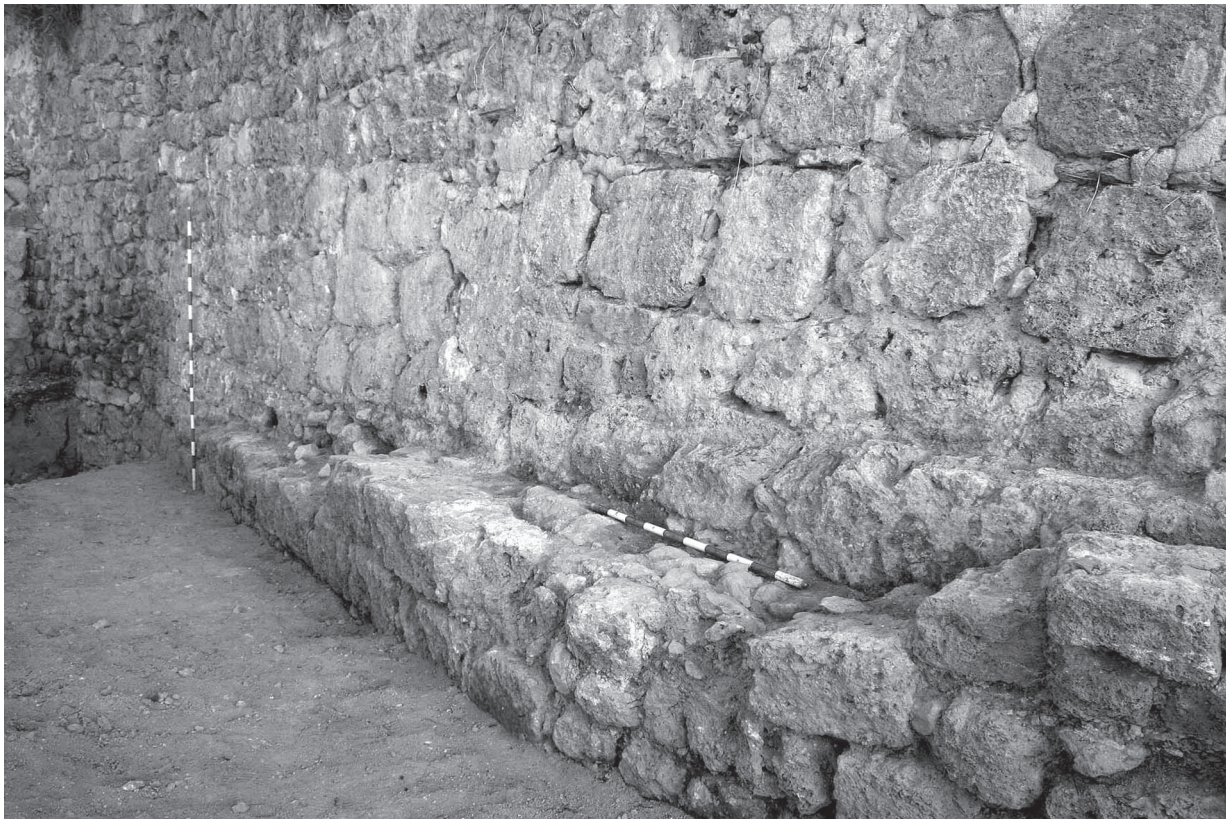
Fig. 38: Sector 5. Detalle de la muralla, las hileras finales de sillares y detalle de la edificación de los muros del Recreo por encima de la muralla, retranqueados.
