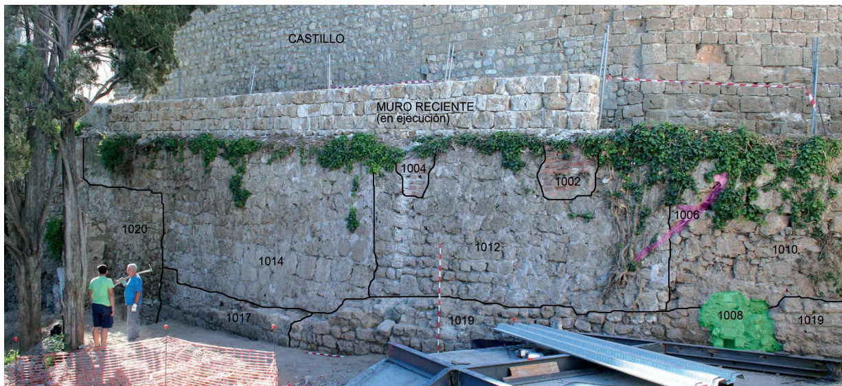
Fig. 40: Sector 5. Vista general de este sector de murallas, con la indicación de las distintas Unidades Estratigráficas Murarias documentadas en el estudio de paramentos realizado.
