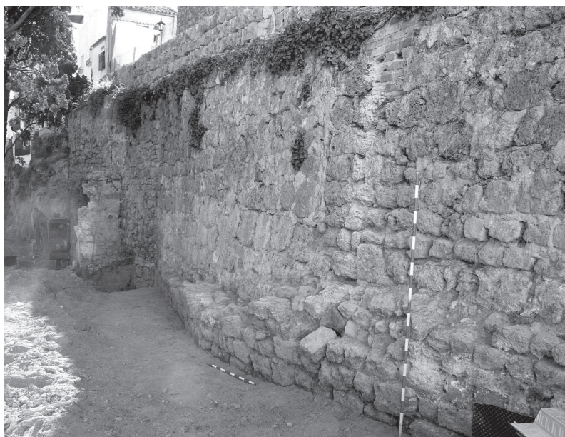
Fig. 31: Sector 5. Lienzos de muralla aparecidos tras la limpieza y desbroce en este sector.
