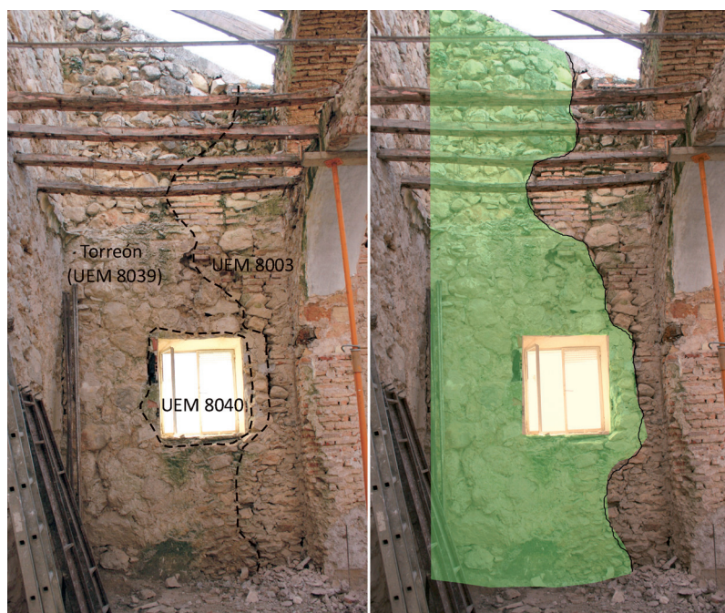
Lám. 4: Paramento 8003. Restos del torreón de 1415.
