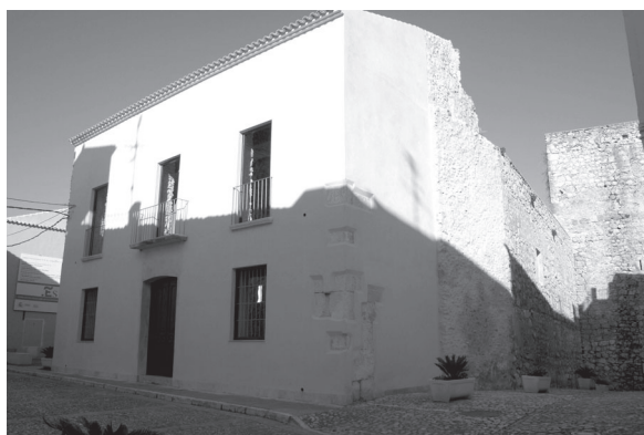
Lám. 14: Fachada del edificio tras su restauración.
