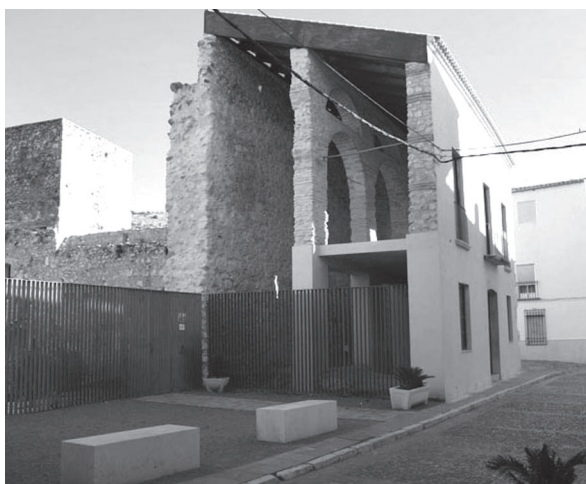
Lám. 12: Vista de los restos del pósito después de la intervención y recuperación.
