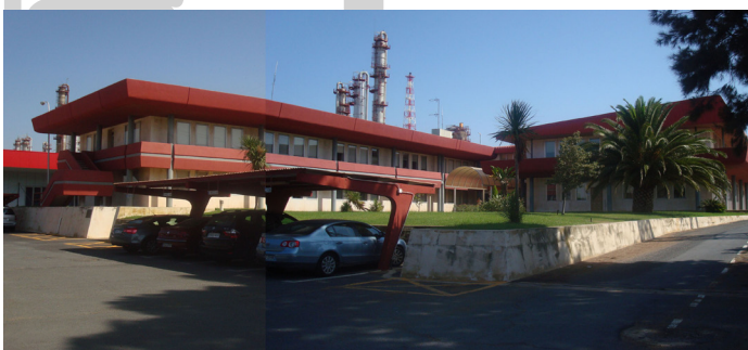
Pabellón para la recepción de visitas de Endesa.
