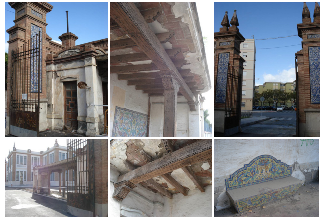
Detalles del patrimonio arquitectónico y artístico de la Fábrica de Tabacos de Málaga
