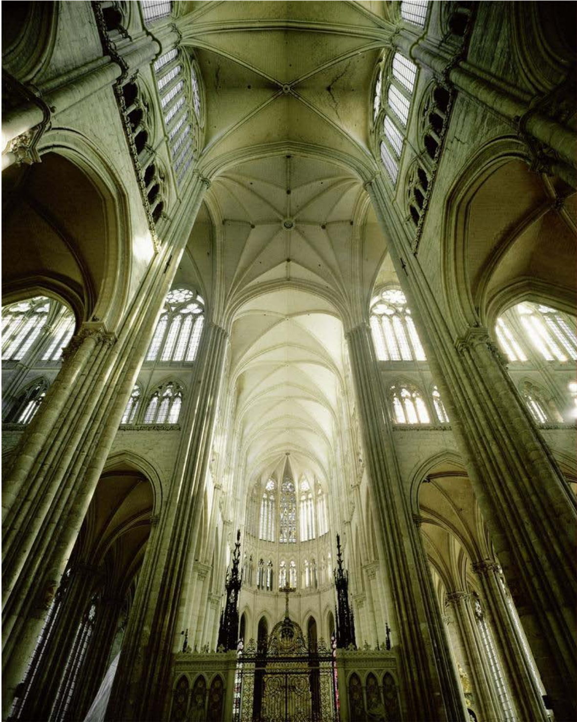
Anexo8: Catedral de Amiens: interior de la nave, coro y bóveda de crucería. ARTstorCollection: Erich Lessing Culture and Fine Arts Archives. Erich Lessing/ART RESOURCE, N.Y.
