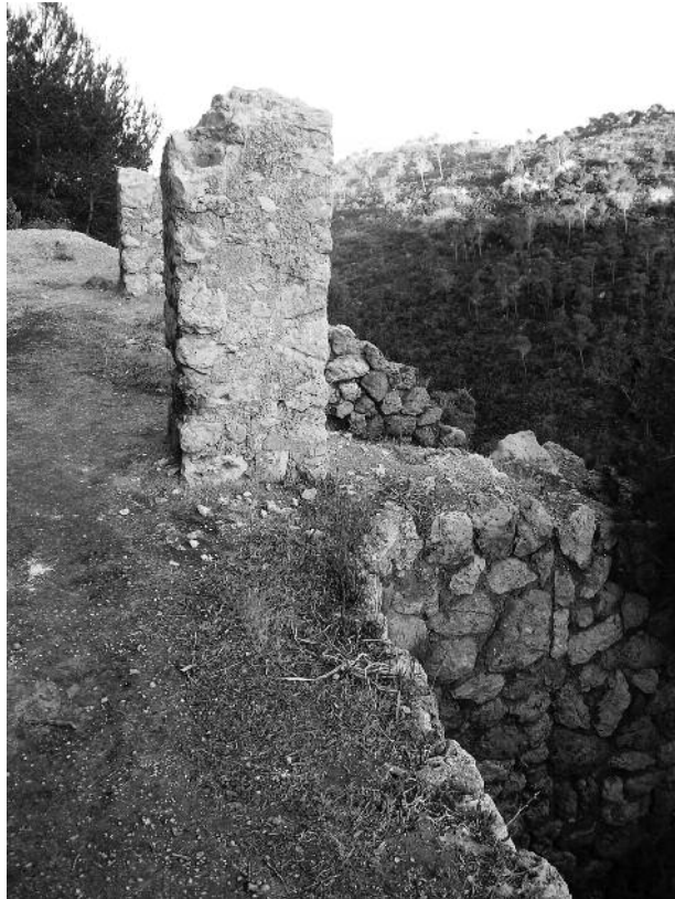
Figura 10. Restos de los hornos de yeso superiores de las minas de las Coves del Pilar (Palma).
