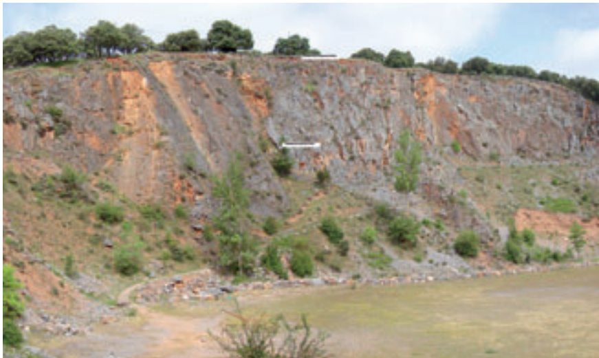
Foto 1. Vista general del Macizo del Encinado con la entrada/salida norte de la Gruta de La Paz y la entrada/salida única de la Gruta de la Viña.
