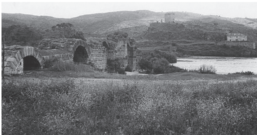
Figura 13. Puente romano de Alconétar sobre el río Tajo, antes de su traslado al cercano cauce del arroyo Guadancil, afluente del Tajo, con motivo de la construcción del embalse de Alcántara. Fotografía de 1969, donde se aprecian el puente y el castillo de Alconétar.
