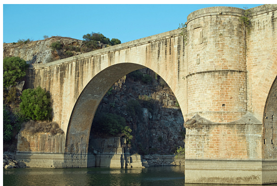
Figura 21. Puente de Almaraz sobre el río Tajo.
