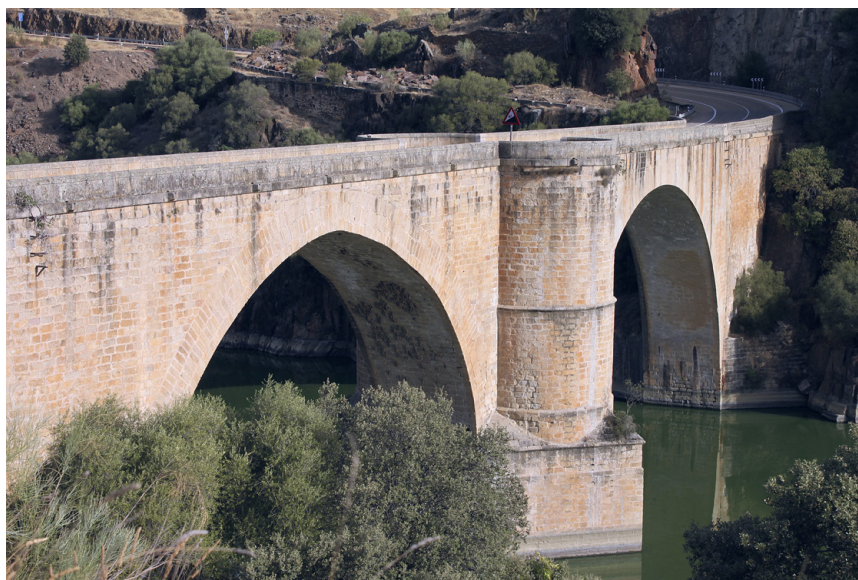
Figura 16. El puente de Almaraz con el camino hacia esta localidad, inicio de la obra del tramo caminero a construir en 1764.
