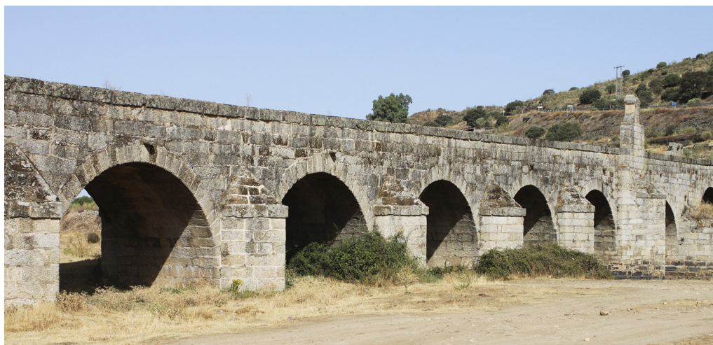
Figura 12. Puente sobre el río Almonte en Jaraicejo.
