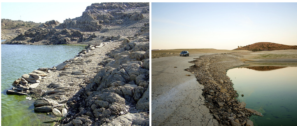
Figura 44 y 45. Restos de la calzada romana y de la antigua N-630. Su visión, indudablemente poética, es metáfora de la desidia de la sociedad hacia el patrimonio de las obras públicas, que es generador de paisajes culturales potencialmente atractivos para el turismo tal y como demuestran diversas actuaciones realizadas en otros países europeos 42 .
