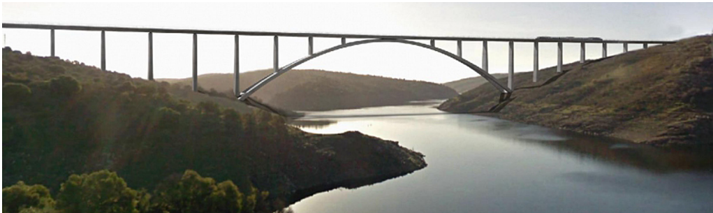
Figura 12. Fotomontaje del puente sobre el Almonte 15 .
