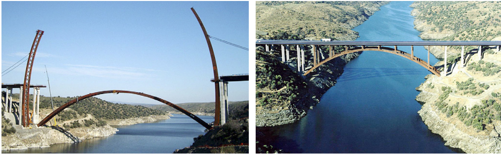
Figuras 10 y 11. Arcos de Alconétar. En la fotografía izquierda, abatimiento de un arco con el otro arco paralelo ya construido. A la derecha, el puente finalizado. Este puente, además, fue la primera estructura en arco donde se dio el fenómeno de la resonancia, fenómeno que consiste en la vibración oscilatoria del puente cuando en su entorno se produce una determinada velocidad del viento. La solución fue añadirle unos deflectores capaces de alterar la trayectoria de la corriente de aire 14 .
