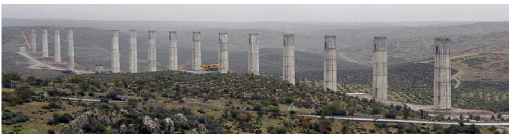
Figura 13. Labores de construcción del viaducto de Valdegravieso.
