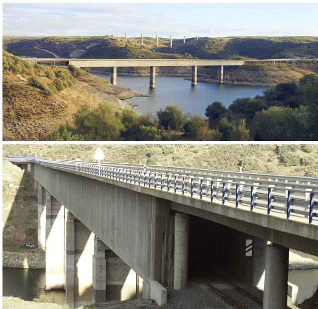
Figuras 5 y 6. Viaductos de Alconétar y de la Plata. Al fondo de la primera foto se observan las obras de construcción del nuevo puente para el AVE.
