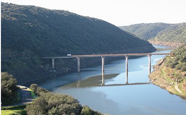
Figuras 7 y 8. Viaductos de Araya y de Serradilla (1969).
