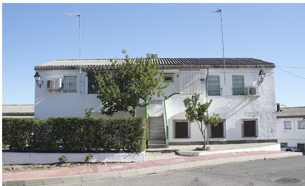
Figura 4. Bloque de viviendas del Poblado nº 2 (J. Teixidó).
