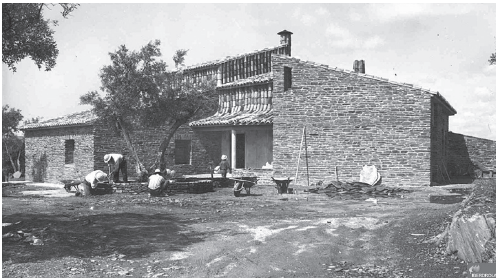
Figura 10. Obras de construcción de la vivienda de dirección de las obras. Se aprecia un uso de materiales más afines con la arquitectura vernácula de la zona (Archivo Iberdrola).
