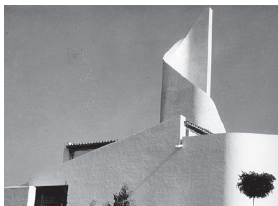
Figura 8. Detalle de la torre de la iglesia del Poblado Permanente (Oriol Arquitectura).
