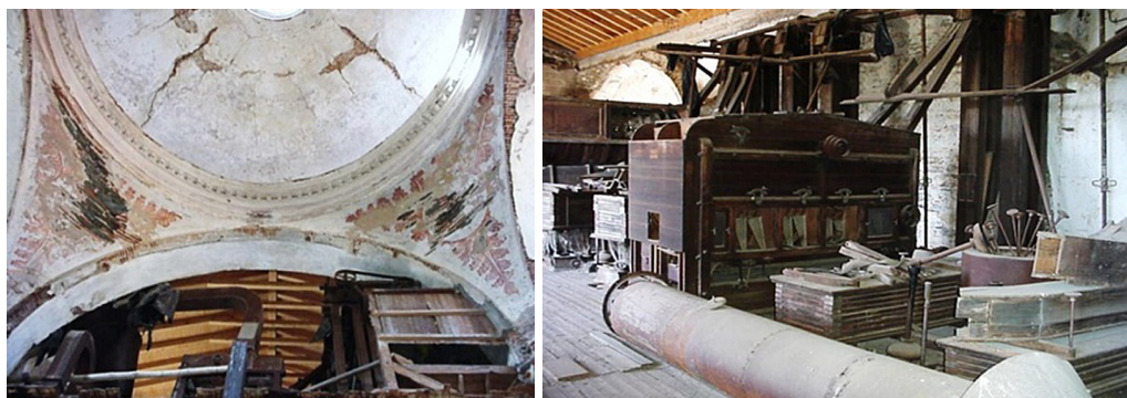
Figura 17. Izda.: detalle desde el crucero de la iglesia a la nave desde donde se aprecia la colocación de la fábrica harinera. Dcha.: maquinaria fabril en la nave del templo.
