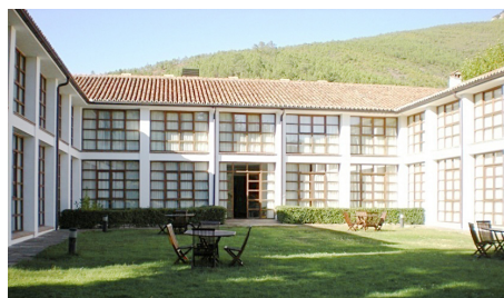
Figura 14. Fotografías del patio como ejemplos para comparar el antes y el después de la intervención en la Factoría como Hospedería.
