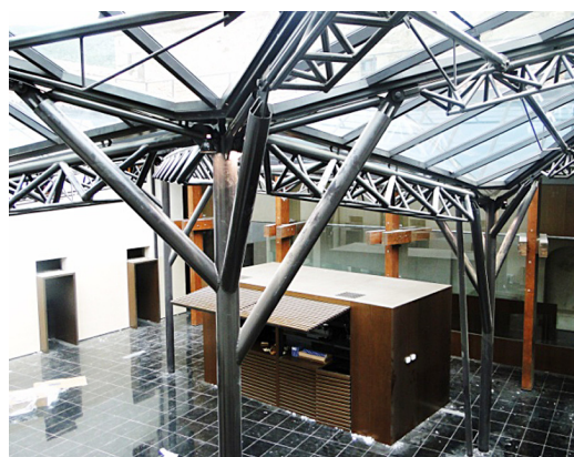
Figura 20. Detalle de la cubierta acristalada en el claustro principal.
