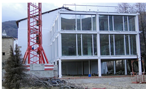
Figura 7. Imagen exterior del nuevo edificio, en fase de construcción, de la zona de ampliación de la Hospedería Valle del Jerte.
