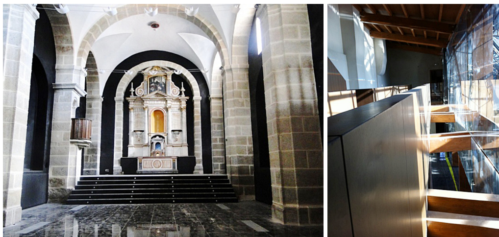
Figura 21. Izda.: antiguo templo reconvertido en el salón de banquetes y celebraciones de la Hospedería. Dcha.: detalle de la nueva rampa de madera colocada en el ala norte del claustro anteriormente desplomada. En estas imágenes se aprecian los contrastes surgidos entre lo original y lo moderno y en relación a los materiales, las texturas y las soluciones técnicas.
