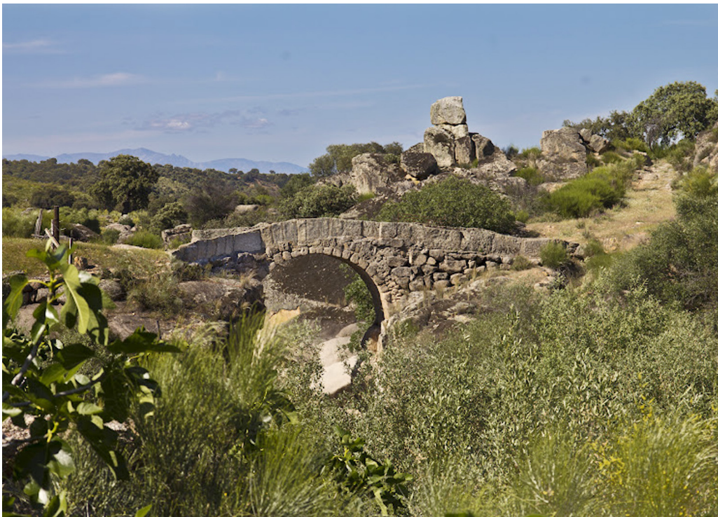
Figura 6. Puente del Búho, en el antiguo término de Talavera la Vieja.
