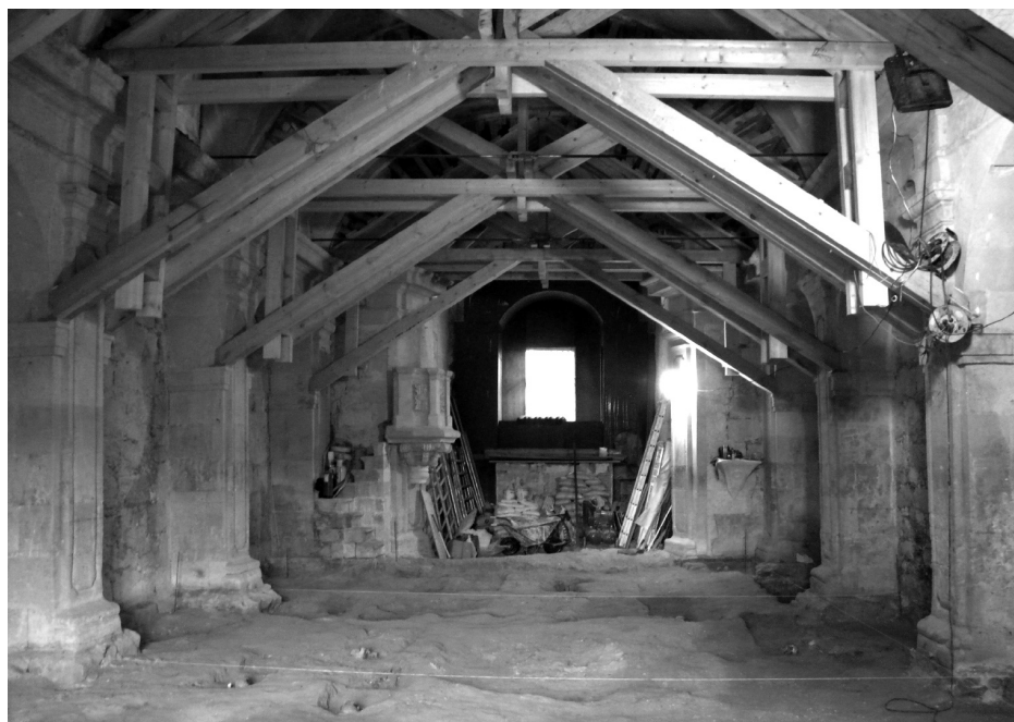
Lám. I: 1. Vista de la ermita de Nuestra Señora de las Angustias al inicio de los trabajos; 2-3. Interior del templo tras los trabajos de excavación, donde se reconocen las estructuras de las fosas de enterramientos detectadas.
