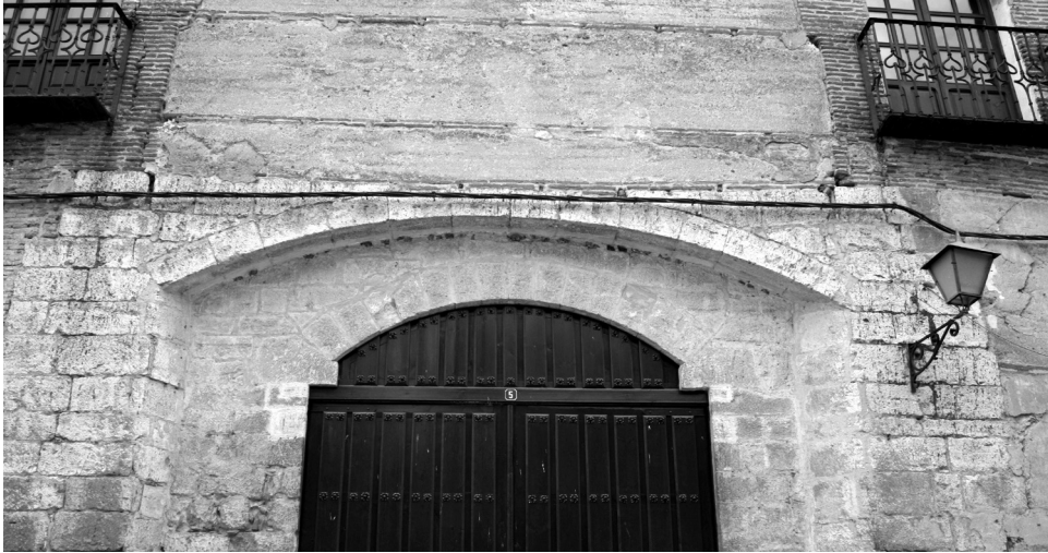
Fig. 3. Palacio de los marqueses de Alcañices. Toro. Detalle de la portada.
