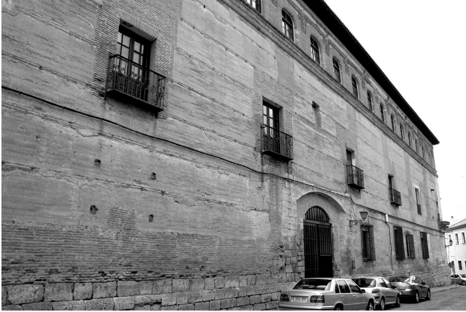
Fig. 1. Palacio de los marqueses de Alcañices. Toro. Fachada.
