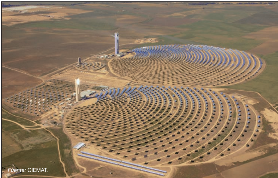
Figura 8.- Solúcar PS-10, PS-20 (Abengoa).
