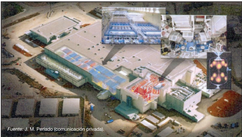
Figura 22. – Láser de Nd cristal con energía de 1,8 megajulios en 3 vatios (= 0,35 micras) con 192 haces y que dará una ganancia energética de 30 como máximo (E por fusión/E de iluminación del blanco por láser).
