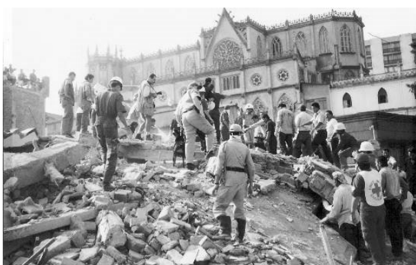
Figura 8. Daños en Pereira Sismo de 1.995
