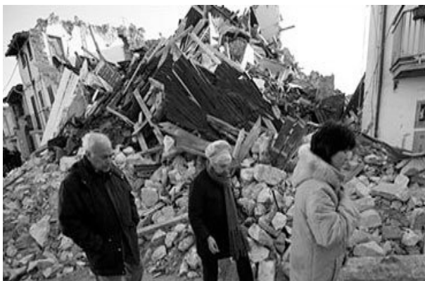
Figura 7. Daños en Popayán sismo de 1.983
