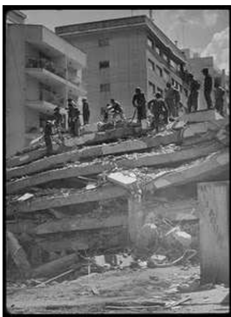
Figura 9. Daños en Armenia sismo de 1.999
