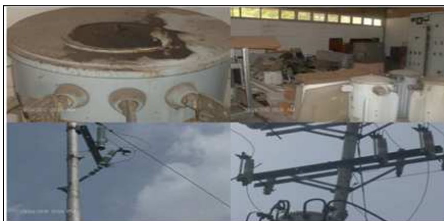
FIGURA 4. Inspección Visual de los Componentes
