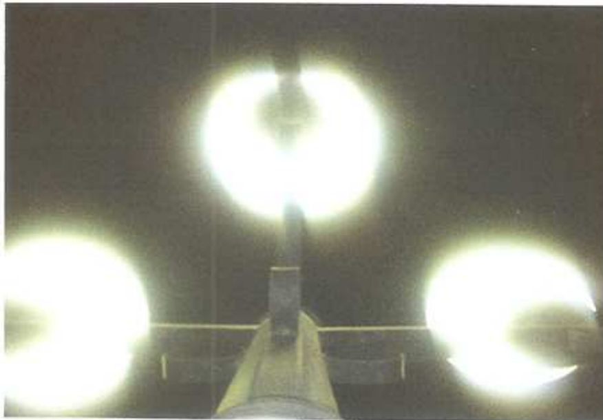
Imagen 3: Poste de tres brazos con lámparas tipo globo. Observar el deslumbramiento hacia el cielo nocturno. (Autor)
