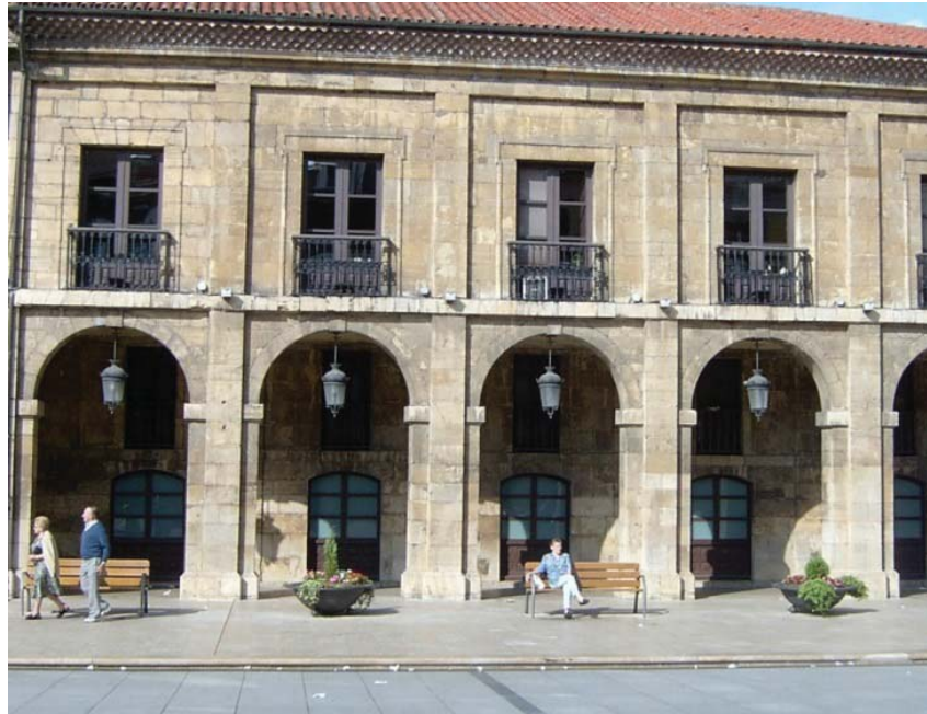
Fig. 8. Crujía oriental del Ayuntamiento de Avilés (Asturias). Juan de Estrada. 1670-1677.
