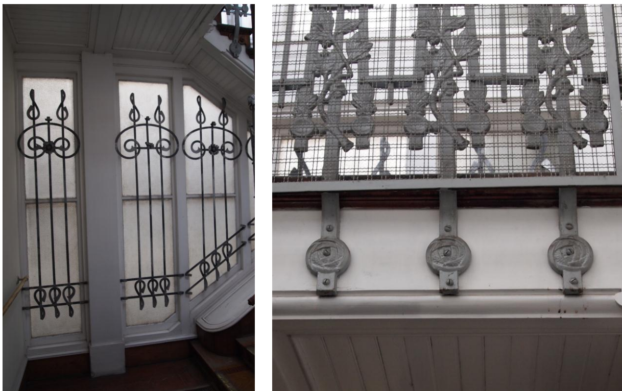
Fig. 9. Casa Rey (1911). Reja de la escalera y detalle del anclaje de la balaustrada con la rosa de Mackintosh. (ARCHIVO Isabel Barro)
