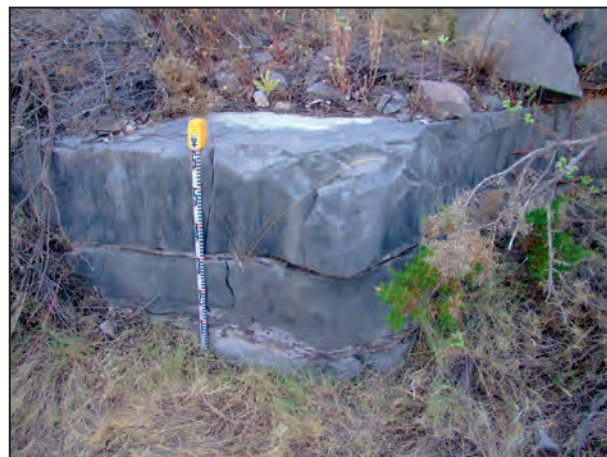
Figura 6. Vista del Panel 2
