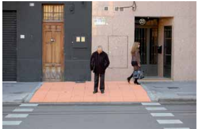
Figura 2. Paso de peatones con las baldosas táctiles de botones.
