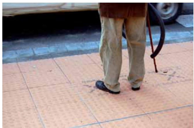
Figura 3. Detalle de la baldosa de botones domótica.
