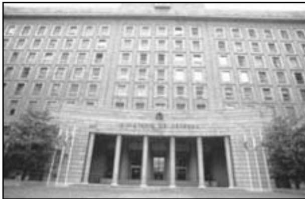
Figura 5. Fachada principal del Ministerio de Defensa.
