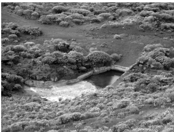
Figura 3. Sistema de recogida de aguas superficiales procedente de la masa forestal en la isla de El Hierro (SANTAMARTA, 2012)
