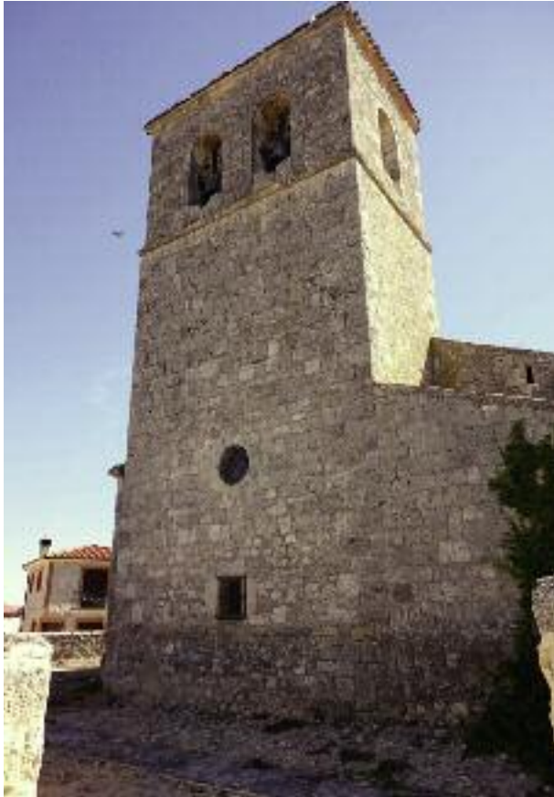
Fig. 3. Torre rural típica clasicista, con zócalo, fuste y campanario separados por imposta plana. Mambrilla de Castrejón.
