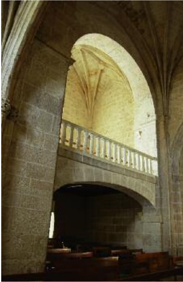
Fig. 6. Interior y exterior de la torre de Santa María en Gumiel de Mercado. La bóveda de crucería que cierra el coro habría sido realizada aún por Pedro Díez de Palacios.
