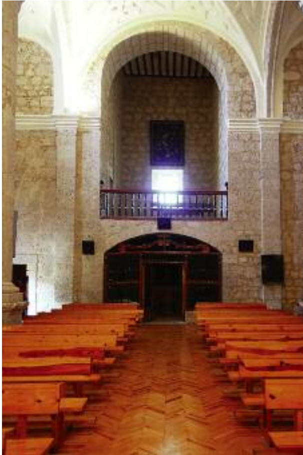
Fig. 10. Interior de la torre de Guzmán, abierta a la nave central del templo con el coro y sotacoro. En la crisis del XVII ya no se cerrarán con bóvedas de crucería sino con simples formados de madera.
