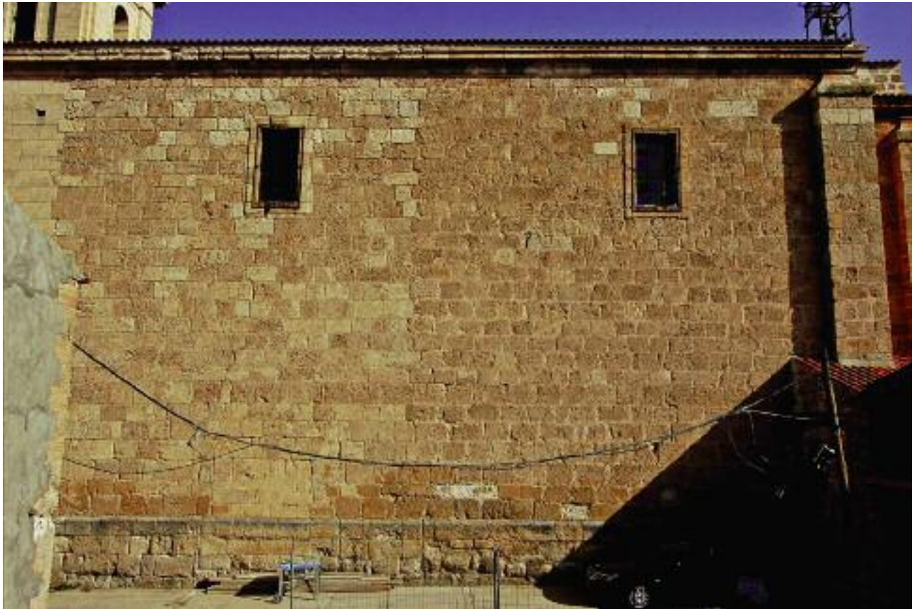
Fig. 16. Muro meridional, mostrando las diferentes fases en la construcción de la obra.
