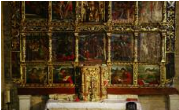
Cuando las maderas del retablo dilataban, toda la mazonería ascendía sin tensiones.
