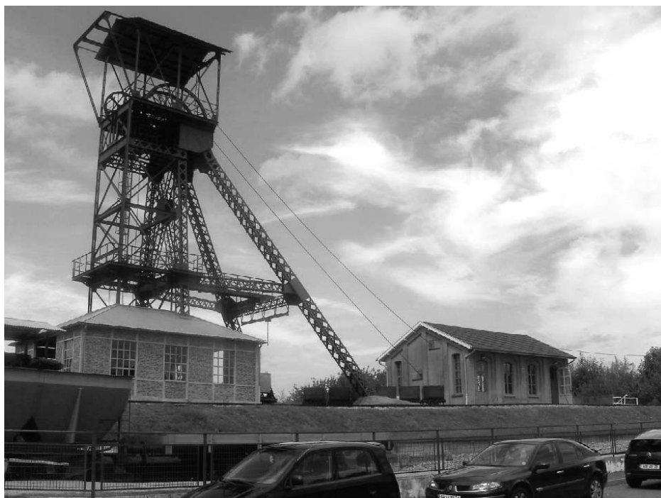
Figura 2. Pozo San Claudio y Sala de Máquinas.
