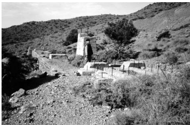
Figura 3. Punto de partida del cable aéreo utilizado por TRAMISA para transportar hasta el lavadero del Rincón de Martos, los materiales de las escombreras de las minas. Este paraje es conocido como “Los Alemanes Nuevos”.
