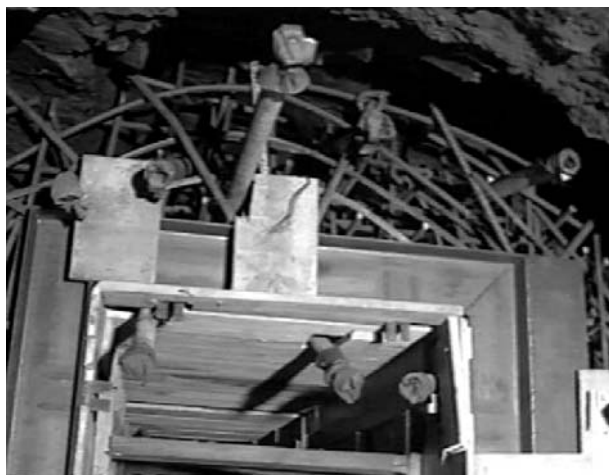
Figura 8. Estructura de cierre aprovechando el dique basáltico para la posibilidad de regular el caudal de agua. (Según Soler Liceras, 1996).
