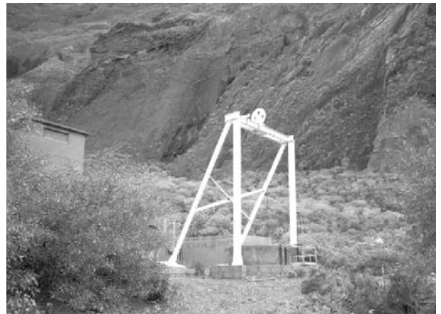
Figura 2. Pozo costero abandonado en la Isla de El Hierro. (Fuente: Santamarta, J., 2008).
