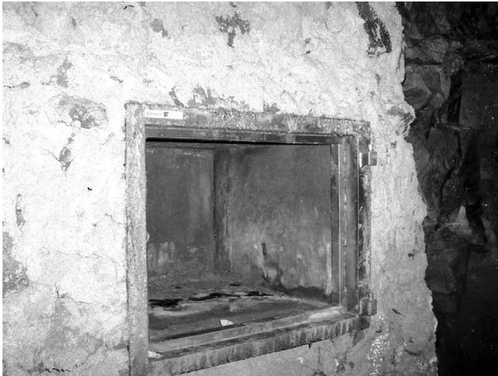
Figura 7. Depósito para el almacenamiento de explosivo dentro de la galería. Deposit for the storage of explosive inside the gallery. (Fuente: Santamarta, J., 2005).
