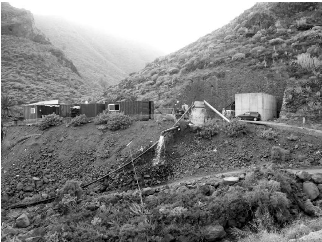
Figura 12. Bocamina de la galería de agua de Ipalam, en la Isla de Gomera. Actualmente se han excavado 2.000 m, obteniéndose un caudal de agua de excelentes calidades para abastecer a la capital de la isla por gravedad. (Fuente: Santamarta, J., 2008).
