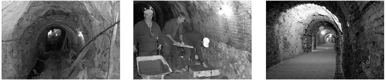
Figura 7. Izquierda, Interior del Túnel Sta. María en 2001. Centro, Trabajos en el interior del Túnel Sta. María en 2003 (Fototeca Fundación Río Tinto). Derecha, Interior del Túnel Sta. María en 2008 (foto ADD).
