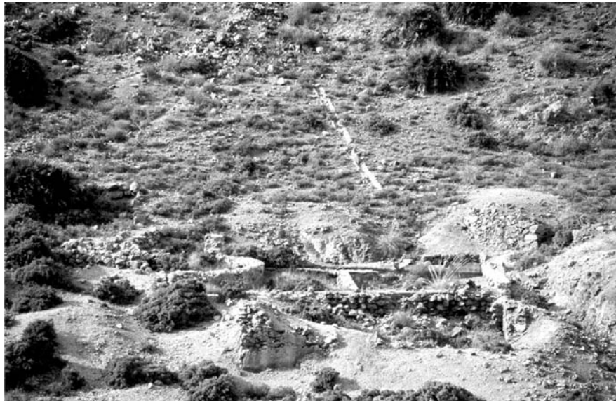
Figura 2. Balsas utilizadas en el proceso de tratamiento.
