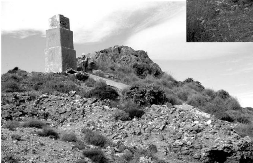
Figura 4. Restos de una peculiar chimenea de la instalación metalúrgica, parte de la cual transcurría sobre el terreno y a favor de la pendiente de la ladera
