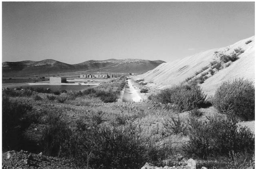
Figura 28. Canal que recogía el líquido enriquecido en oro.
