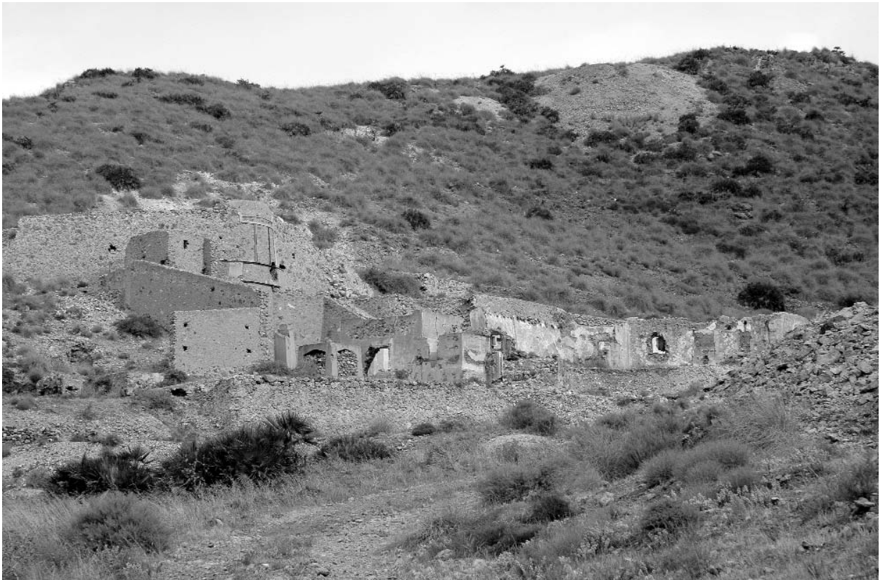
Figura 9. Instalación metalúrgica aurífera de amalgamación de la mina "María Josefa"
