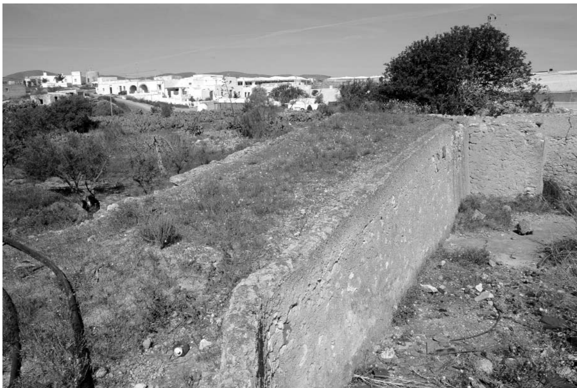
Figura 26. Rampa para recepcionar el mineral y comenzar el proceso metalúrgico.
