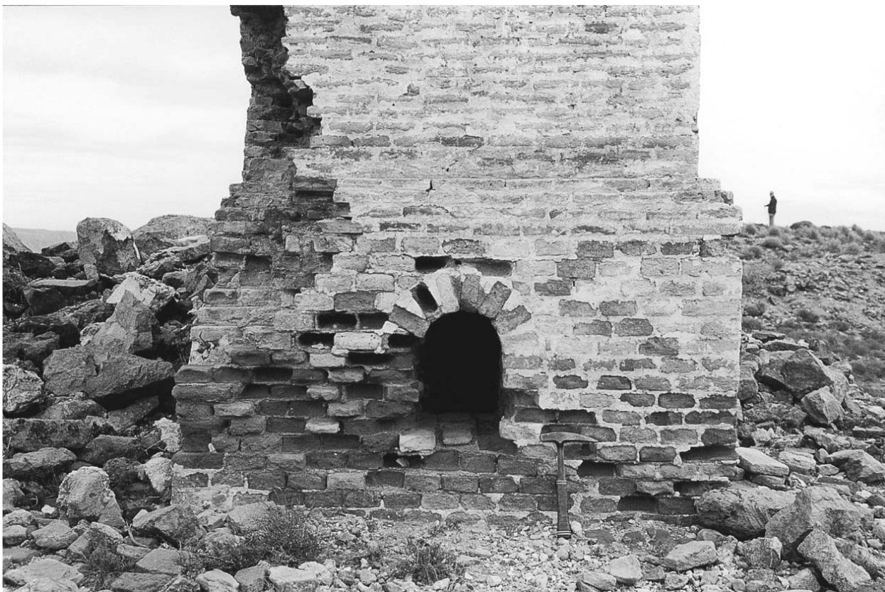
Figura 8. La base de la chimenea de las instalaciones.
