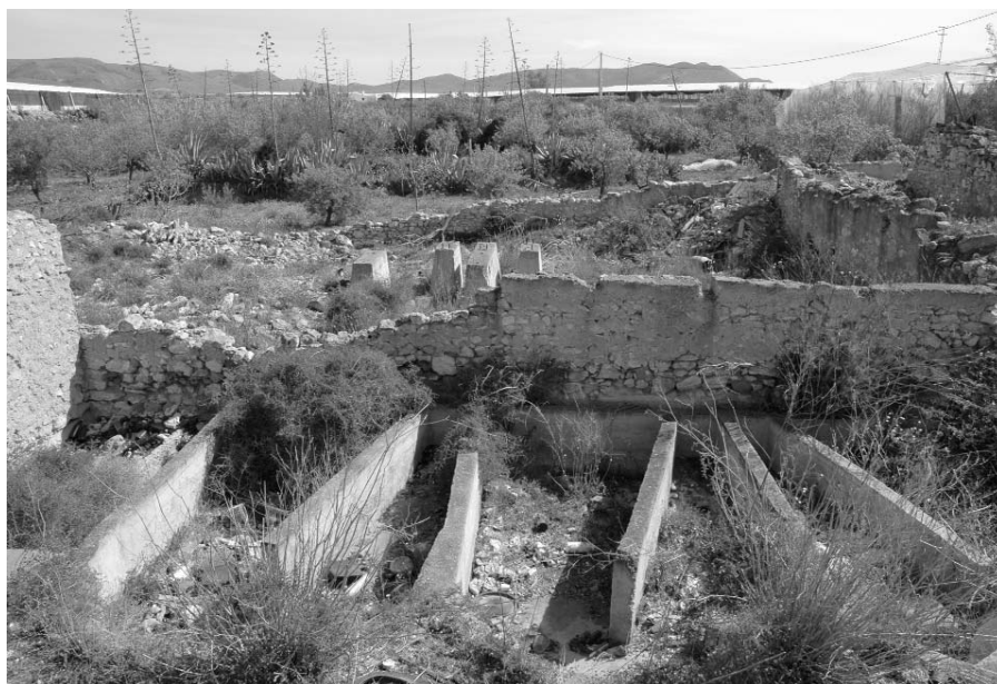
Figura 25. Bancadas y canales de la instalación.
