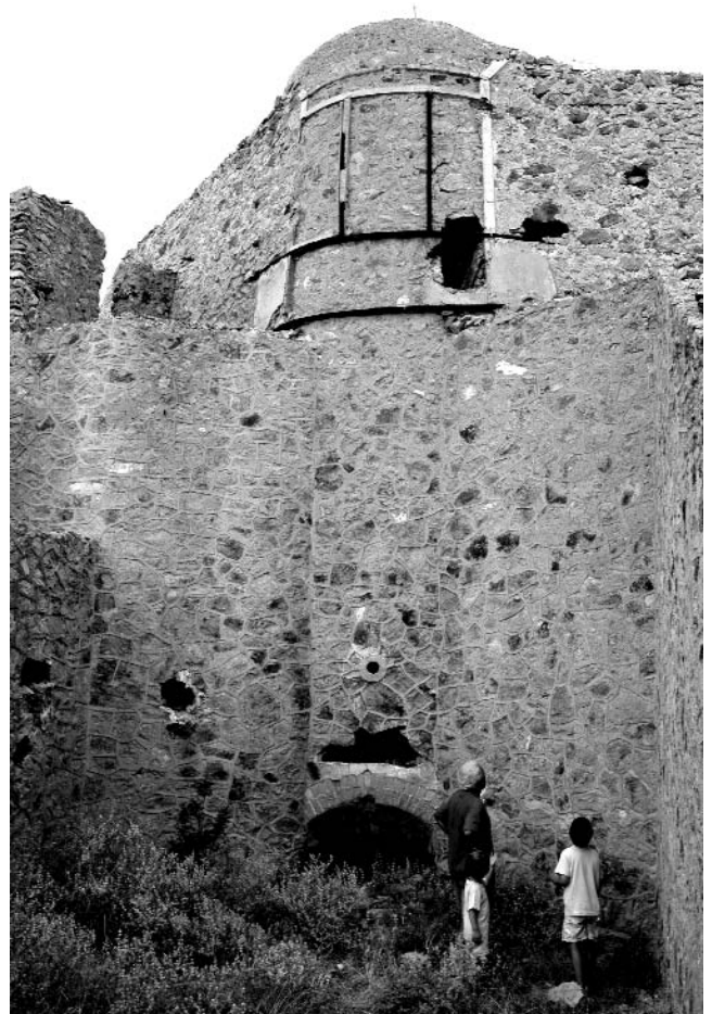
Figura 10. Horno de cuba en donde, al parecer, se caldeaba el mineral antes de su trituración.
