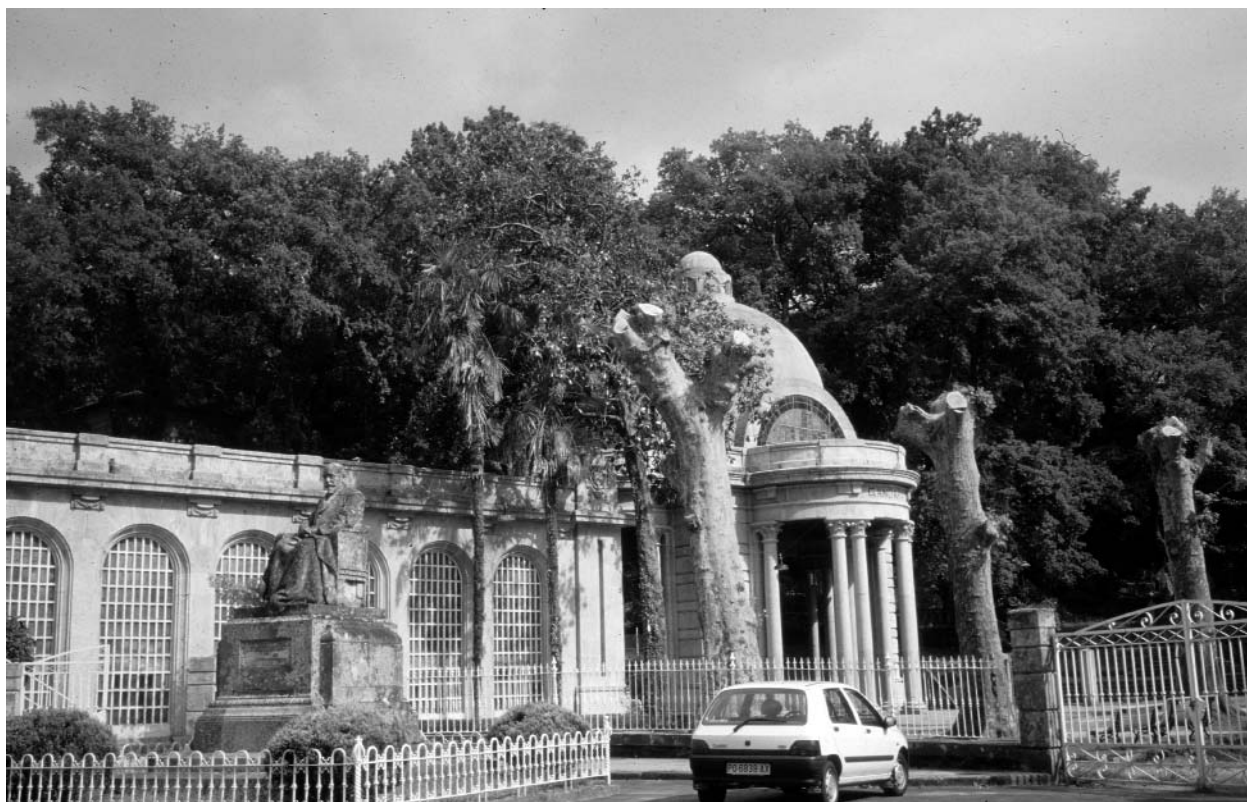
Figura 9. Fuente de la Gándara, en el balneario de Mondariz (Pontevedra).
