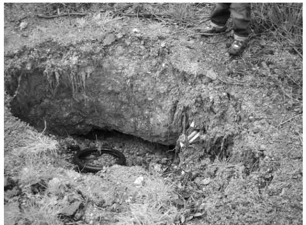
Figura 3. Foto de uno de los numerosos hundimientos que se aprecian en la superficie del terreno, encima de labores mineras.
