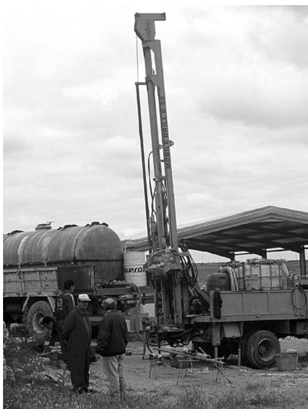
Figura 2. Realización del sondeo en la cantera.
