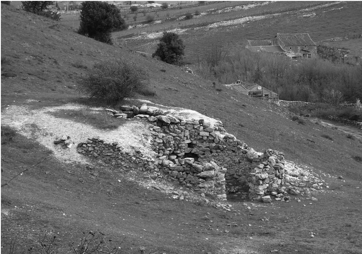
Figura 5. Horno Z-4 semiexcavado en la ladera con su portal delantero.
