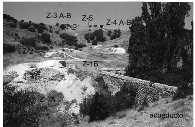
Figura 1. Vista general del conjunto de hornos desde el este con el acueducto en primer término.
