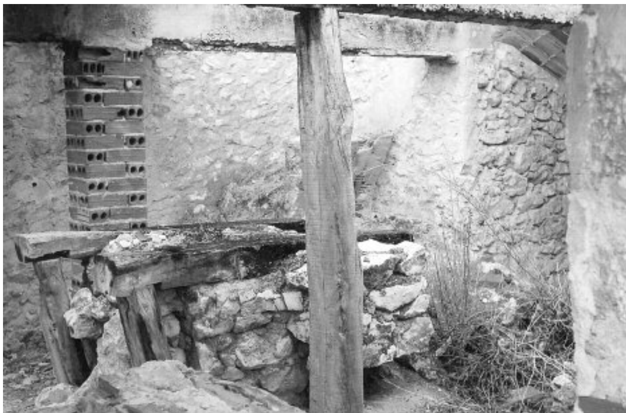
Figura 10. Interior casa de molienda, bancada para la machacadora. Los Tarrollas.
