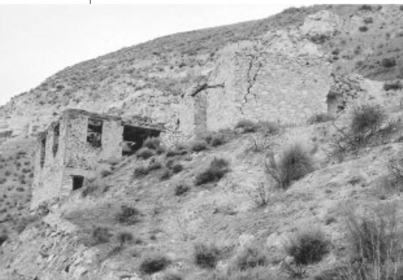
Figura 8. Vista general de los hornos y edificio de molienda.
