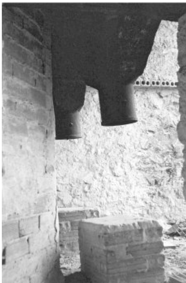
Figura 12. Dos de las tolvas vistas desde el interior. Los Tarrollas.
