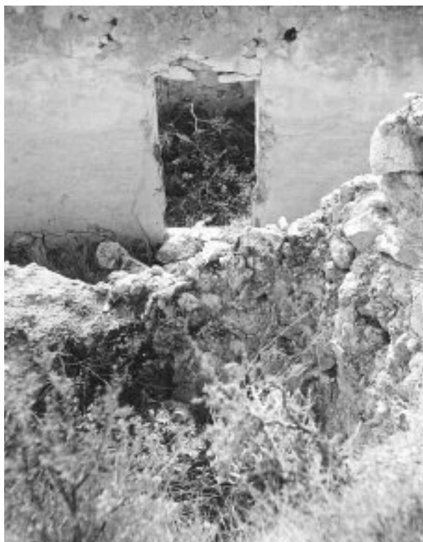
Figura 18. Casa de molienda vista desde un horno. Yesería de D. Juan Gómez.
