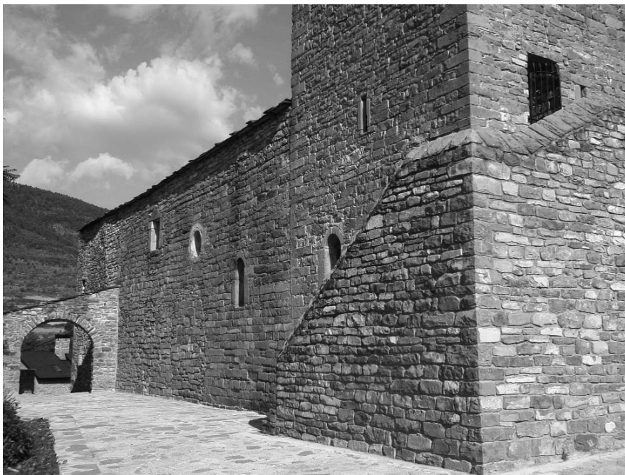
Figura 8. Iglesia de San Miguel. Mampostería muy homogénea debido a la regularidad de espesores de las capas turbidíticas. Castiello de Jaca (Huesca).
