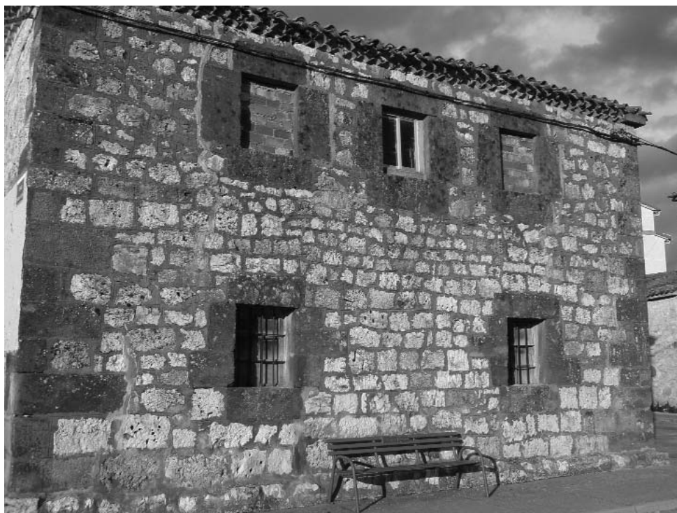
Figura 9. Construcción tradicional. San Millán de Juarros (Burgos). Empleo de areniscas triásicas rojas en esquinales y vanos y calizas cretácicas como elemento estructural de muro (sillería).
