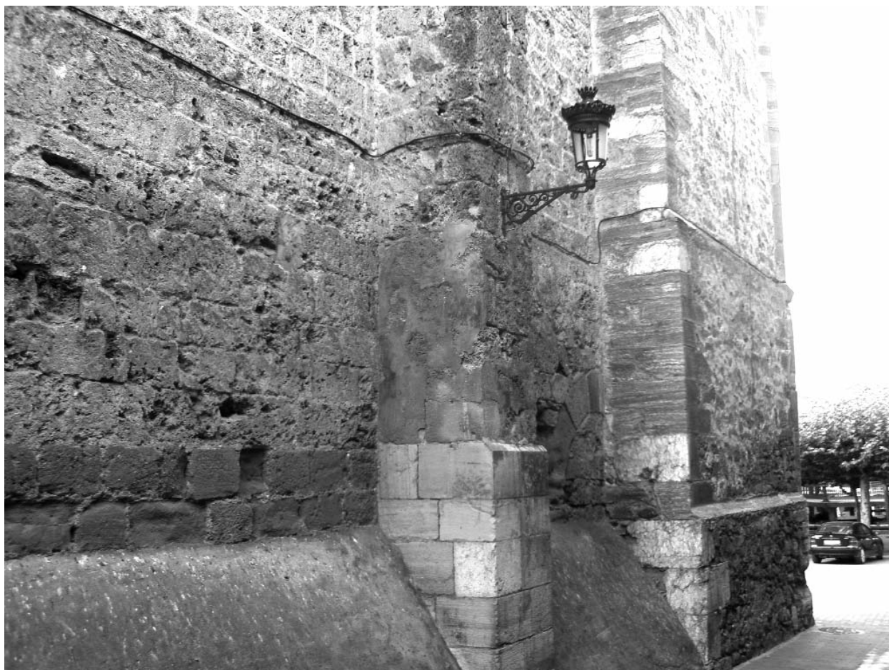
Figura 2. Iglesia de San Pedro (Belorado, Burgos). Empleo de yesos miocenos como sillar en contrafuertes.
