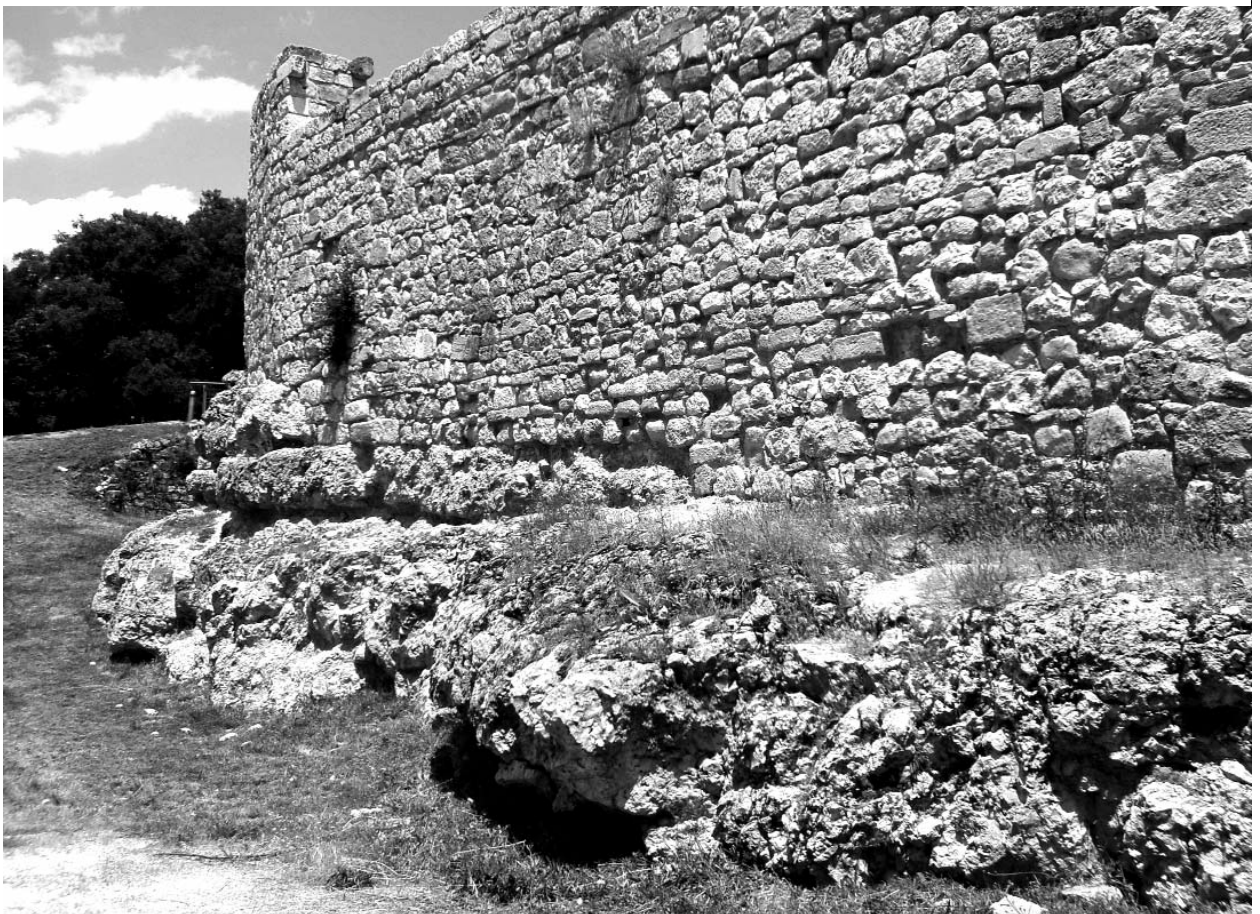
Figura 4. Castillo (Burgos). Afloramiento de calizas de los páramos (mioceno superior) empleadas como mampostería.
