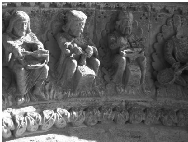
Figura 6. Detalle de elementos escultóricos, modulación y repetición sistemática. Iglesia de Santiago, Carrión de los Condes (Palencia).
