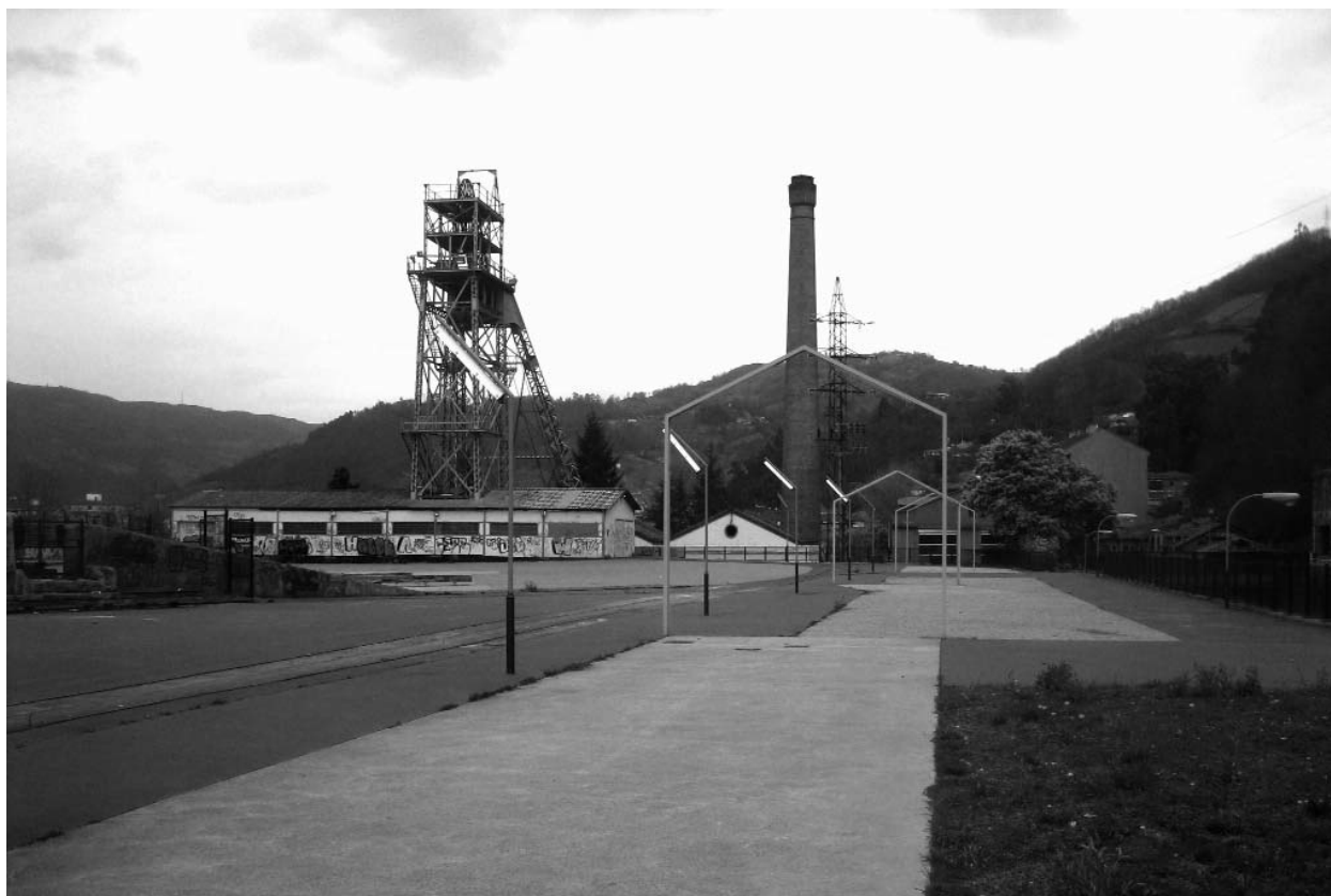
Figura 5. La plaza del pozo en la actualidad. Donde antes se ubicaban las naves de talleres, hoy únicamente se conservan sus pórticos metálicos.
