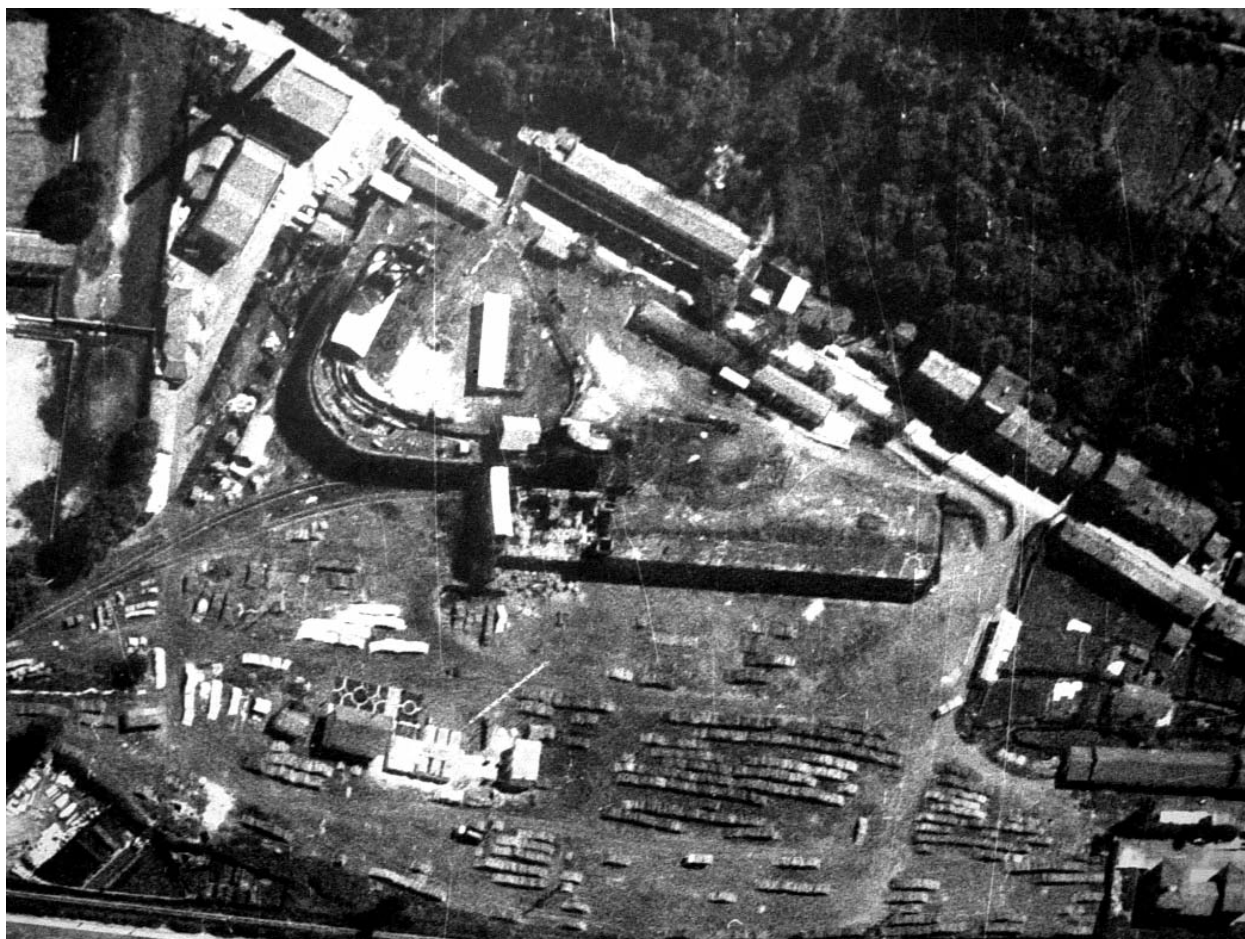
Figura 2. Vista aérea de la explotación. Puede observarse la plaza de la madera y las instalaciones de superficie sobre la plaza del pozo. Años 60 del siglo XX.
