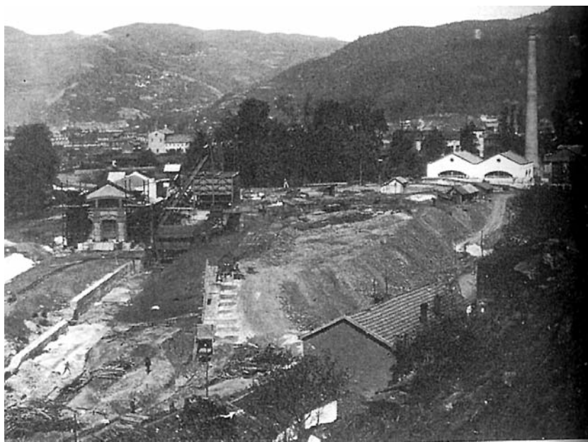
Figura 1. Imagen de la explotación antes de la profundización del pozo vertical.
