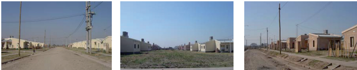
Figura 17. Fotografías del sector 128 viviendas
