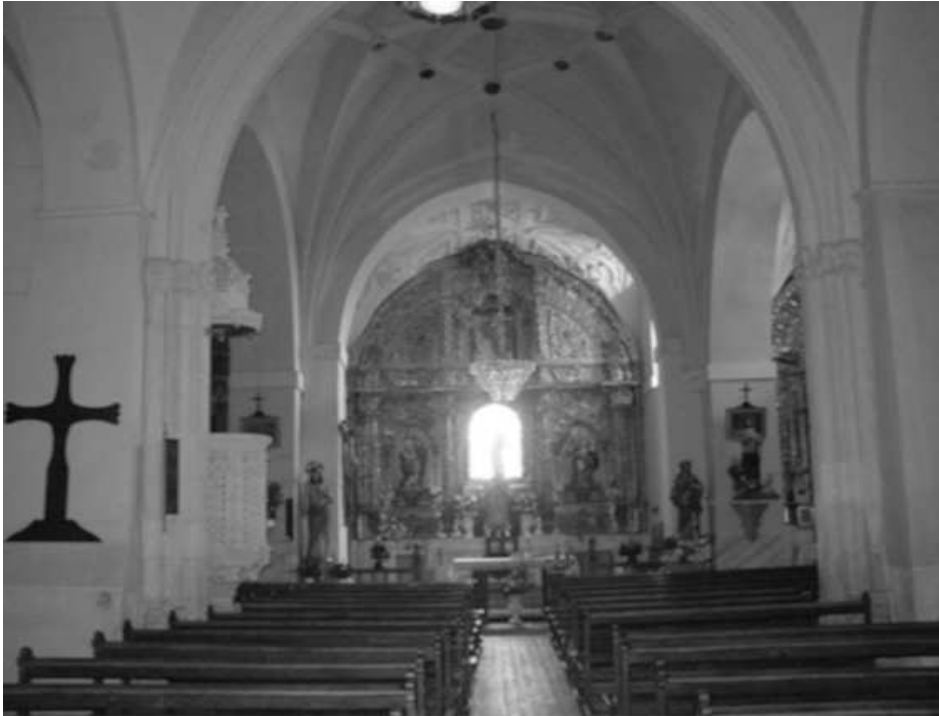
Fig. 4.- Interior de la Iglesia parroquial. Planta de cruz latina, nave central gótica del siglo XV, cúpula rebajada con bóveda de crucería estrellada en el crucero. Las naves laterales son ampliación del primer tercio del siglo XVIII.
