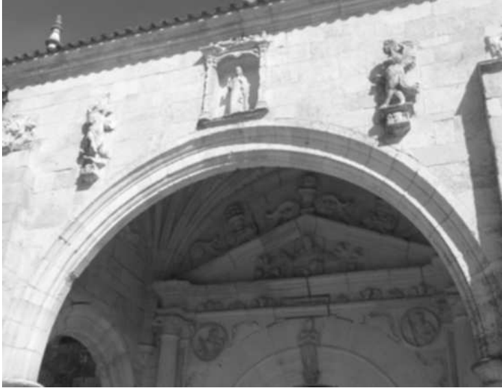
Fig. 6.- Detalle del pórtico.
