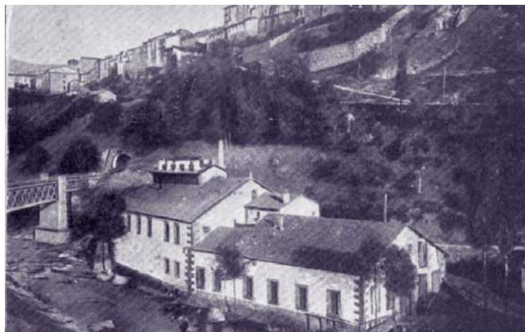
Puente Ferrocarril, tunel y fabrica
