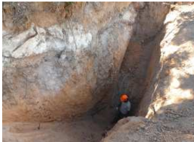
Fotografies 12 i 13. Podem veure la imatge de la secció de la canalització del desaiiguament fora del pou, i a la dreta, imatge del sondeig per localitzar aquest conducte a l'exterior.
