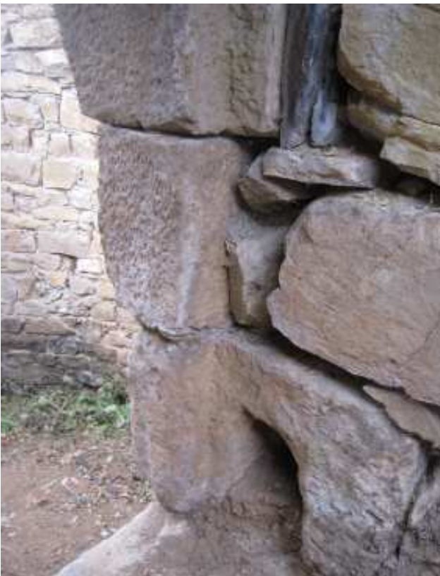
Fotografies 40 i 41: Dos detalls de l'accés al pou. Costat dret mirant el pou. S'hi veuen molt bé els orificis per encabir-hi els suports d'una hipotètica porta.
