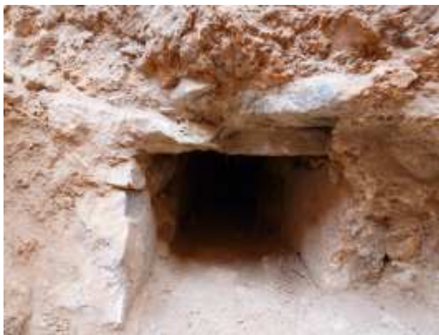
Fotografies 12 i 13. Podem veure la imatge de la secció de la canalització del desaiiguament fora del pou, i a la dreta, imatge del sondeig per localitzar aquest conducte a l'exterior.
