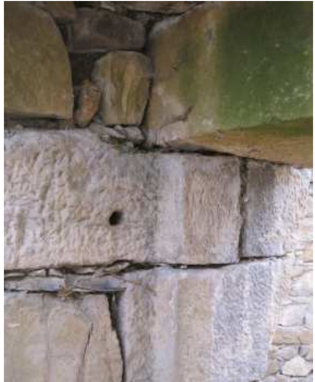
Fotografies 38 i 39: Detalls de l'accés al pou, a l'esquerra observem la pedra tallada seguint la curvatura de tancament de la cúpula. A la dreta apreciem un orifici per encabir-hi algun passador per assegurar una hipotètica porta.
