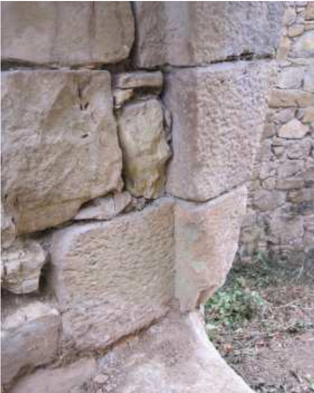
Fotografies 38 i 39: Detalls de l'accés al pou, a l'esquerra observem la pedra tallada seguint la curvatura de tancament de la cúpula. A la dreta apreciem un orifici per encabir-hi algun passador per assegurar una hipotètica porta.
