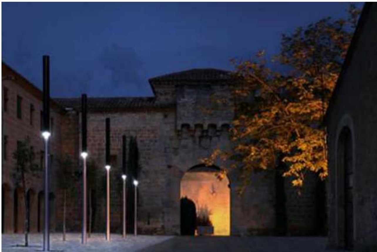
Faroles fotovoltaïques davant de la Porta Daurada. El cilindre fosc de la part superior capta l'energia solar i la transforma en electricitat que alimenta els LEDS.
