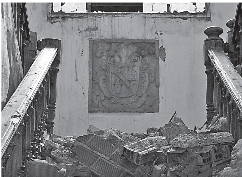
Figura 1. Inmueble histórico de gran valor, en ruinas y completamente abandonado, en el Bajo Aragón.
