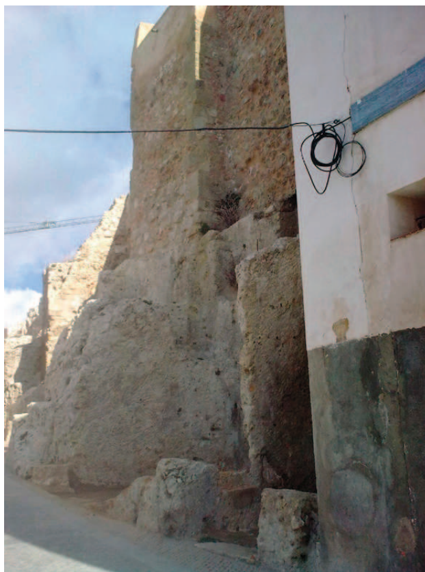
Ilustración 7. Muralla de la Cuesta y Plaza del Carmen. Forma parte del mismo complejo del que estamos tratando en este artículo, concretamente el cierre de la Judería por el SW. Al haberse retirado las casas colgadas que tapaban torres y lienzos de este sector, es hoy el punto donde mejor se aprecian y entienden las fortificaciones que podemos encontrar en la trasera de las casas de las Calles Mosén Diego Valera y Alfonso VIII / Fotografía tomada por SDDS
