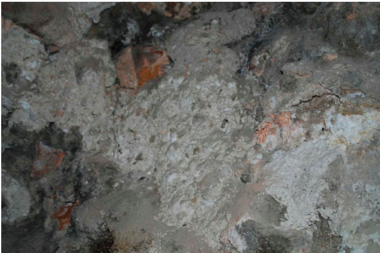
Fig. 11. Piedras de río en núcleo de cal y mampuesto UEM 2 / Fotografía tomada por MMG
