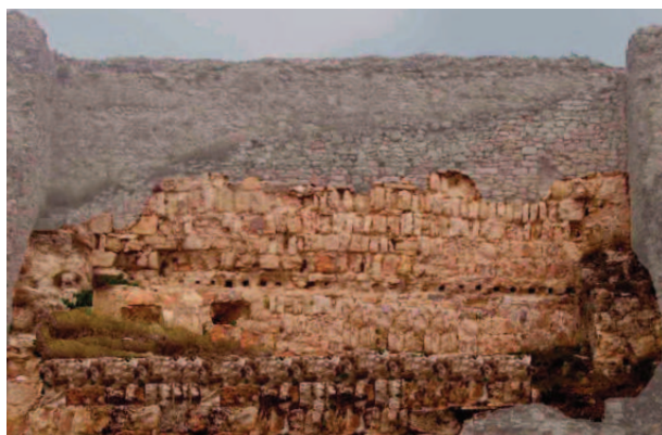
Fig. 4. Restos del primer torreón fundacional del Castillo con paramentos en tizón / Fotografía tomada por MMG
