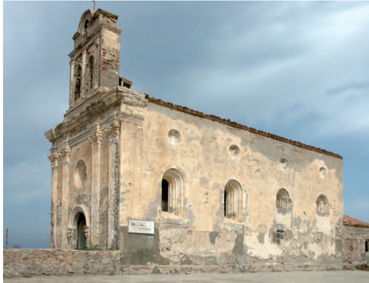
Fachada y nave lateral, 2005. Fotografía ABN.
